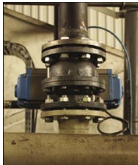
In de plant te Anwerpen-Kiel werd vooral voor ‘Ball Valves’ geopteerd
